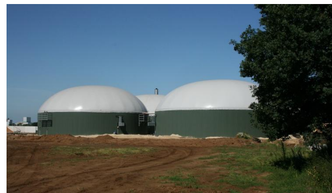
Instalações de recolha de biogás
